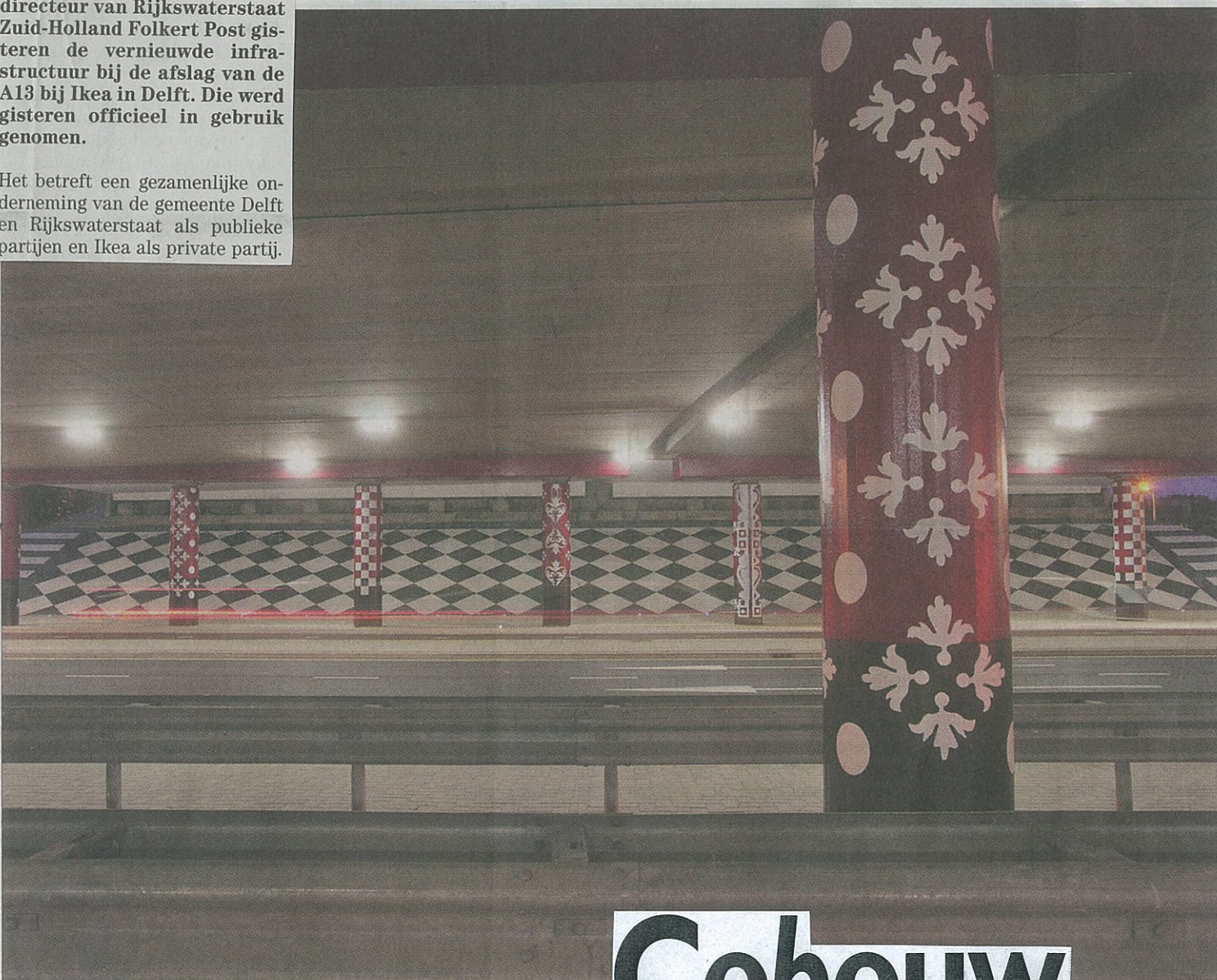
Van het viaduct onder de A13 is een kunstwerk gemaakt.
